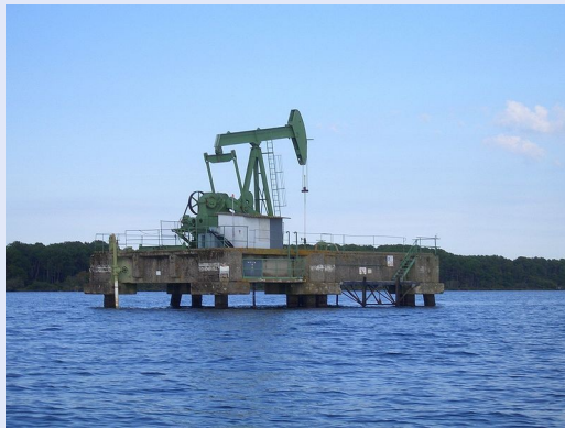
Station de pompage pétrolière sur le lac de Parentis
